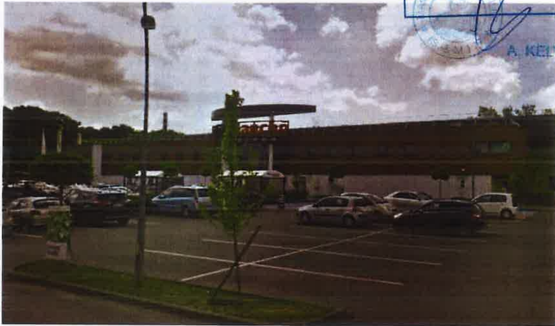
FACADE ETAT EXISTANT
